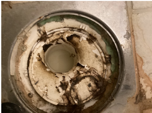
Bilde av sluk.
