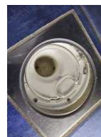
Tettesjiktets tilslutning til sluk - Sluk i bad.
