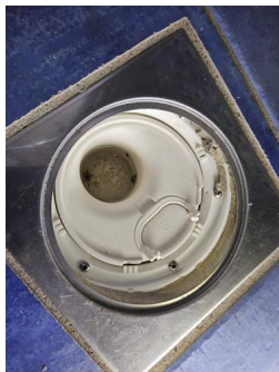
Tettesjiktets tilslutning til sluk - Sluk i bad.
