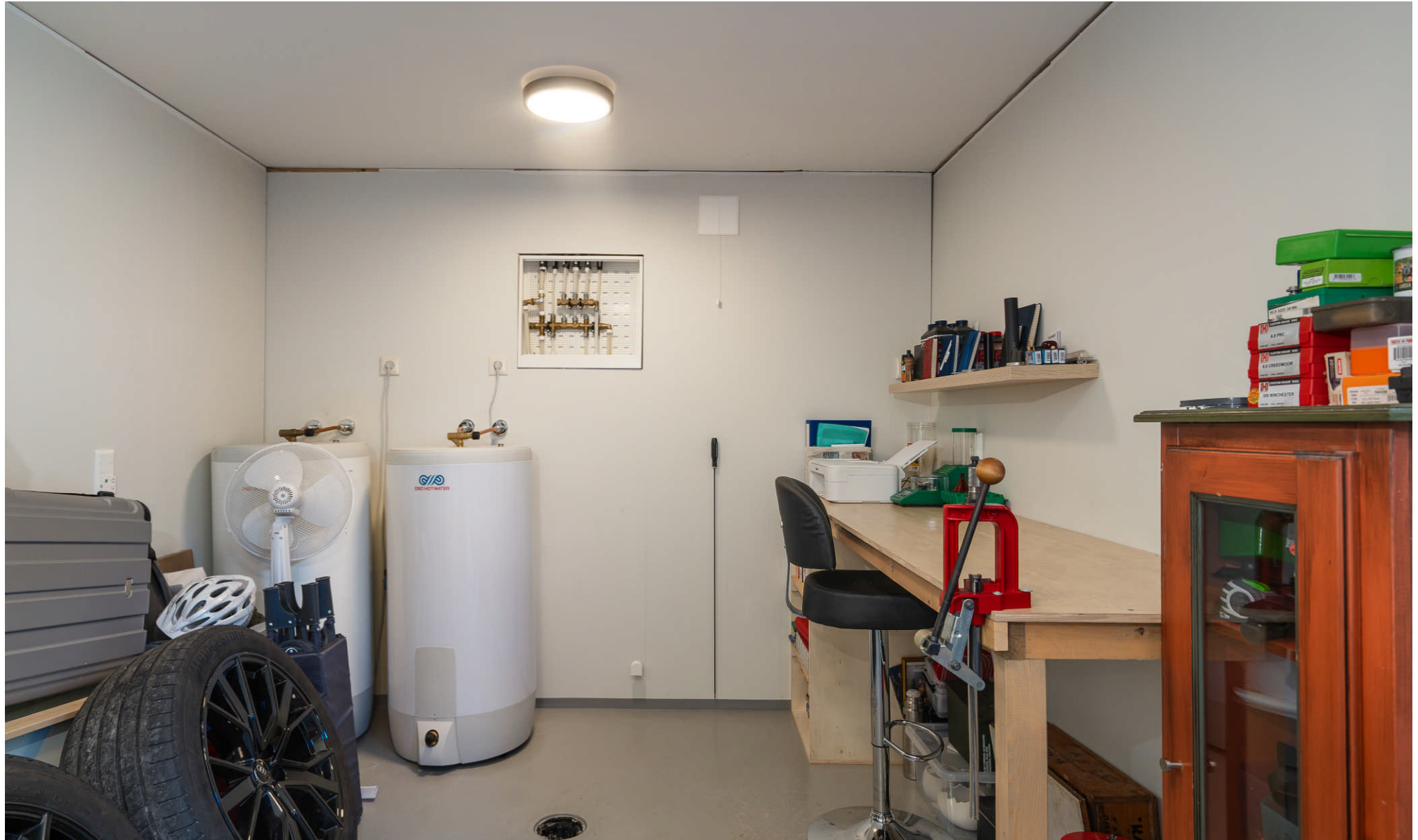
Bod/teknisk rom i underetasje. Den er isolert og har varmekabler i gulv.
