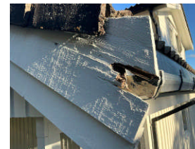
Råte i vindski. Det er anbefalt å bytte ut vindskier på boligen, da det er råte i flere av disse.
