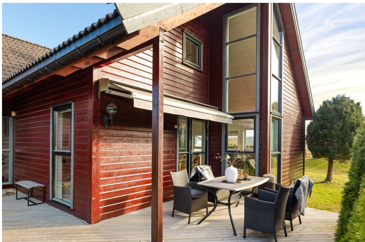
Elektriske markiser på terrassen.
