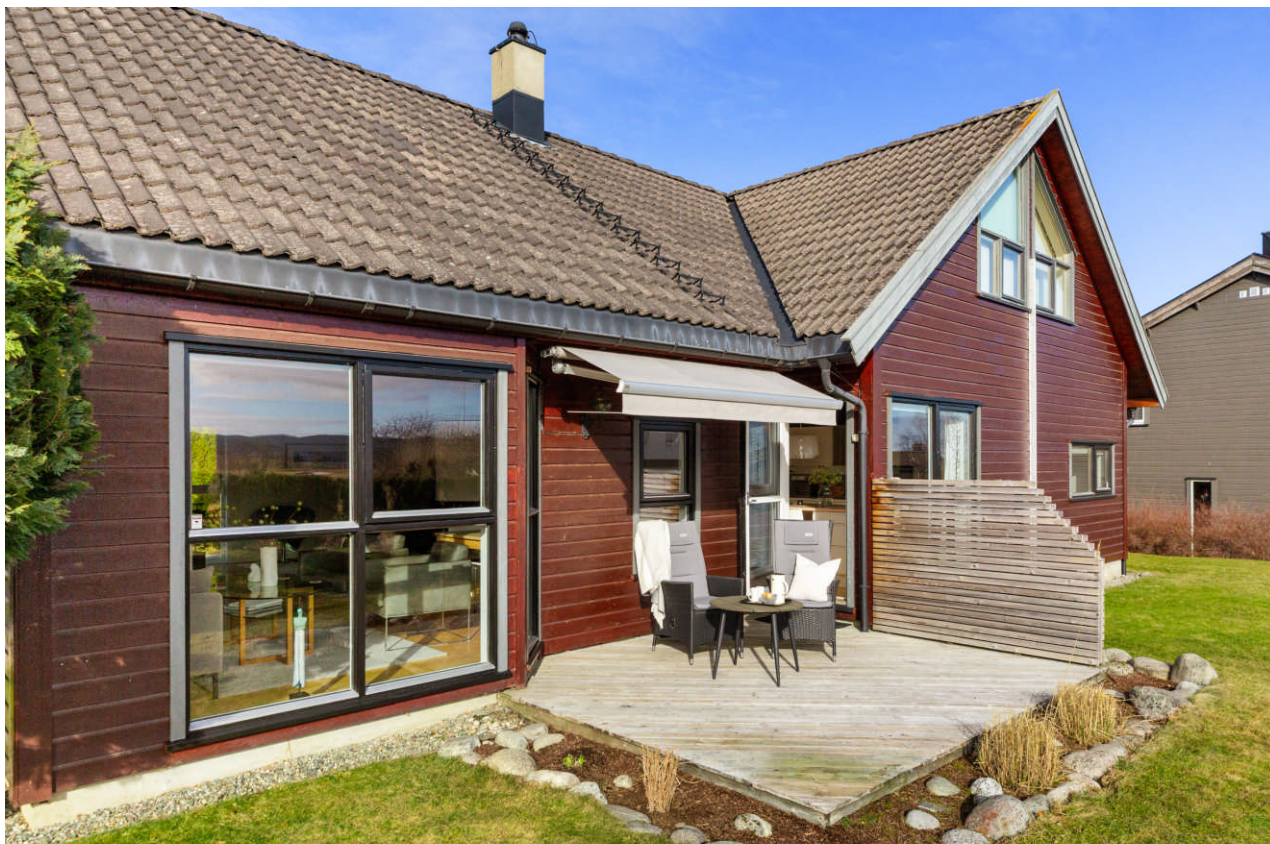
På husets sørøstlige side er det en liten platting på ca. 12 kvm. med utgang fra kjøkkenet. Markise og spilevegg for skjerming.
