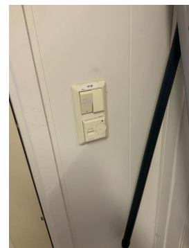
ETASJE > VASKEROM MED KJØKKENINNREDNING
