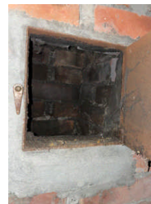
Feierluke etablert i krypkjeller.
