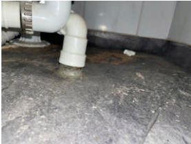
Gjennomføring av avløpsrør i gulv til badekar, under badekar.
