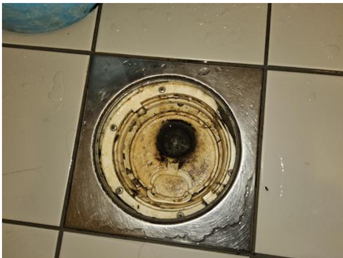
Membran, tettesjikt og overgang til sluk. - [Sluk på badet ]
