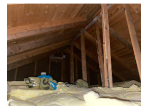
Bildet tatt fra loftsluke.
