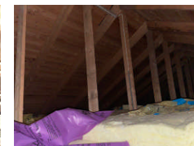
Bildet tatt fra loftsluke.
