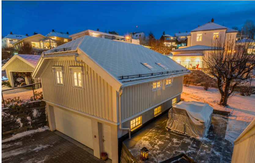
Stor dobbelgarasje. Andre etasje er byggemeldt som snekkerverksted og oppbevaring. I tillegg er det lagringsloft over 2.etasje.
