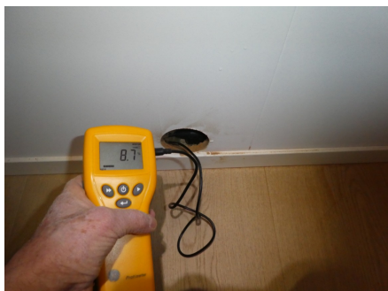
Skillevegg mellom gang og bad
