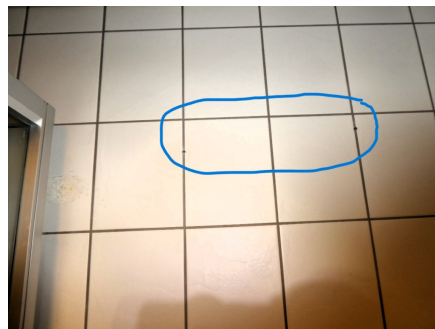
Reoperasjoner ett hull i flis og membran i våtsone
