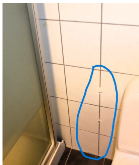
Reoperasjoner ett hull i flis og membran i våtsone
