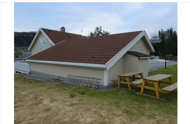
Carport med boder
