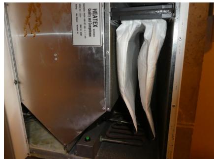
Eier har skiftet filter i anlegget
