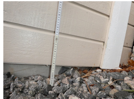
Yttervegg og kledning nær terreng
