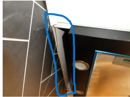
Åpning opp til overskapet for ventilatoren
