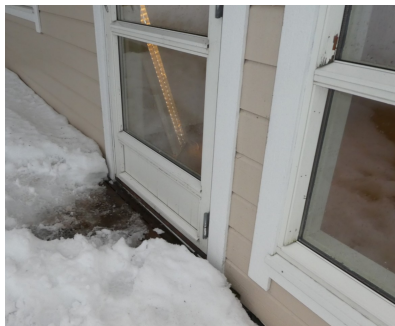
Tilslutning av terrasse gulv mot vegg/dør
