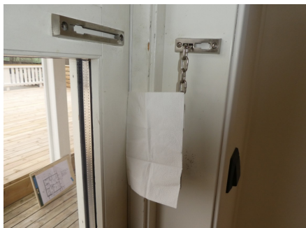
Lite klem mellom list og dørblad - papirarket kan dres gjennom
