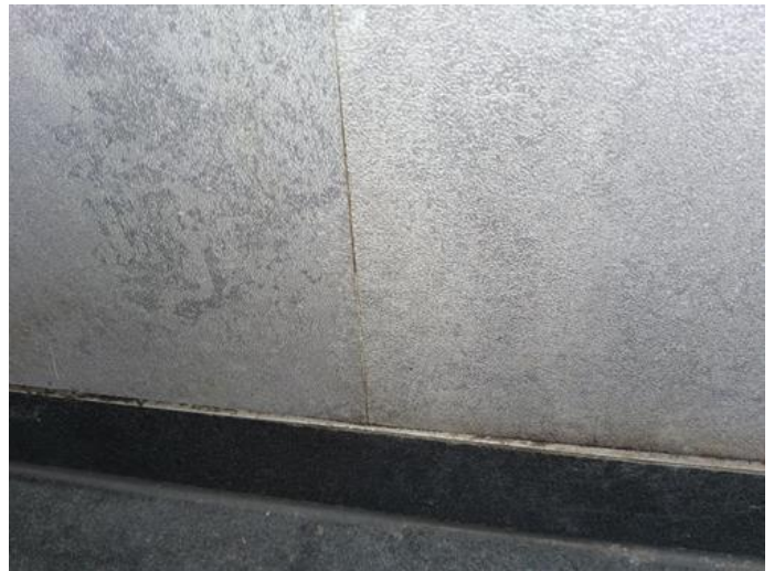
Kommentar - [Slitasje våtromsplater i dusjonen ]
