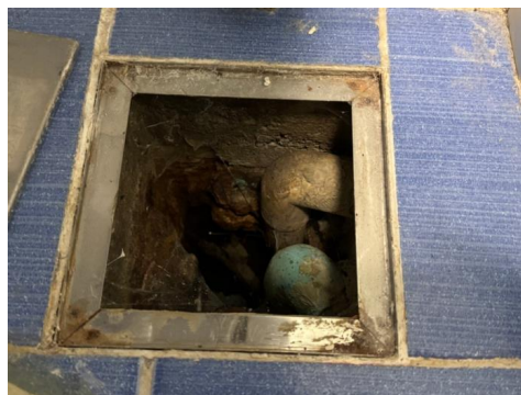
Eldre støpejernsluk i gulv.
