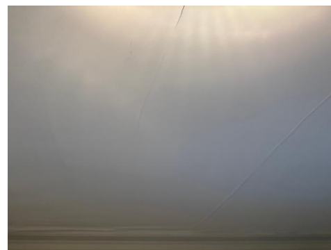
Ujevnheter i lerret duk på soverom i 2-etg.
