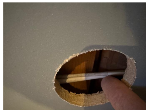
El. ledninger inni vegg i spisestuedel i 1-etg er ikke trukket i trekkerør. Dette er feil utførelse og er et TG 3 avvik.
