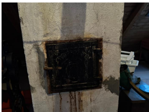
Rust og eldre rennemerker rundt feieluke i loft-etg.
