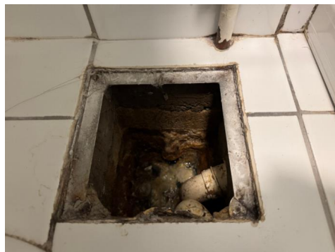
Eldre støpejernsluk i gulv.
