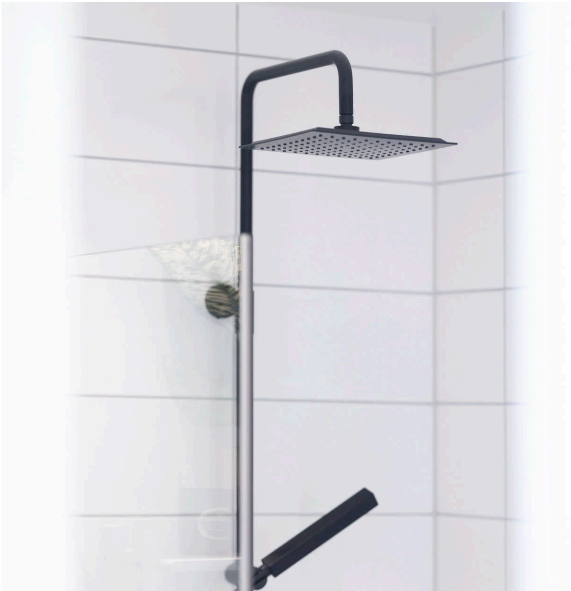
Detaljbilde fra bad 2. etasje. Dusj med takdusj.
