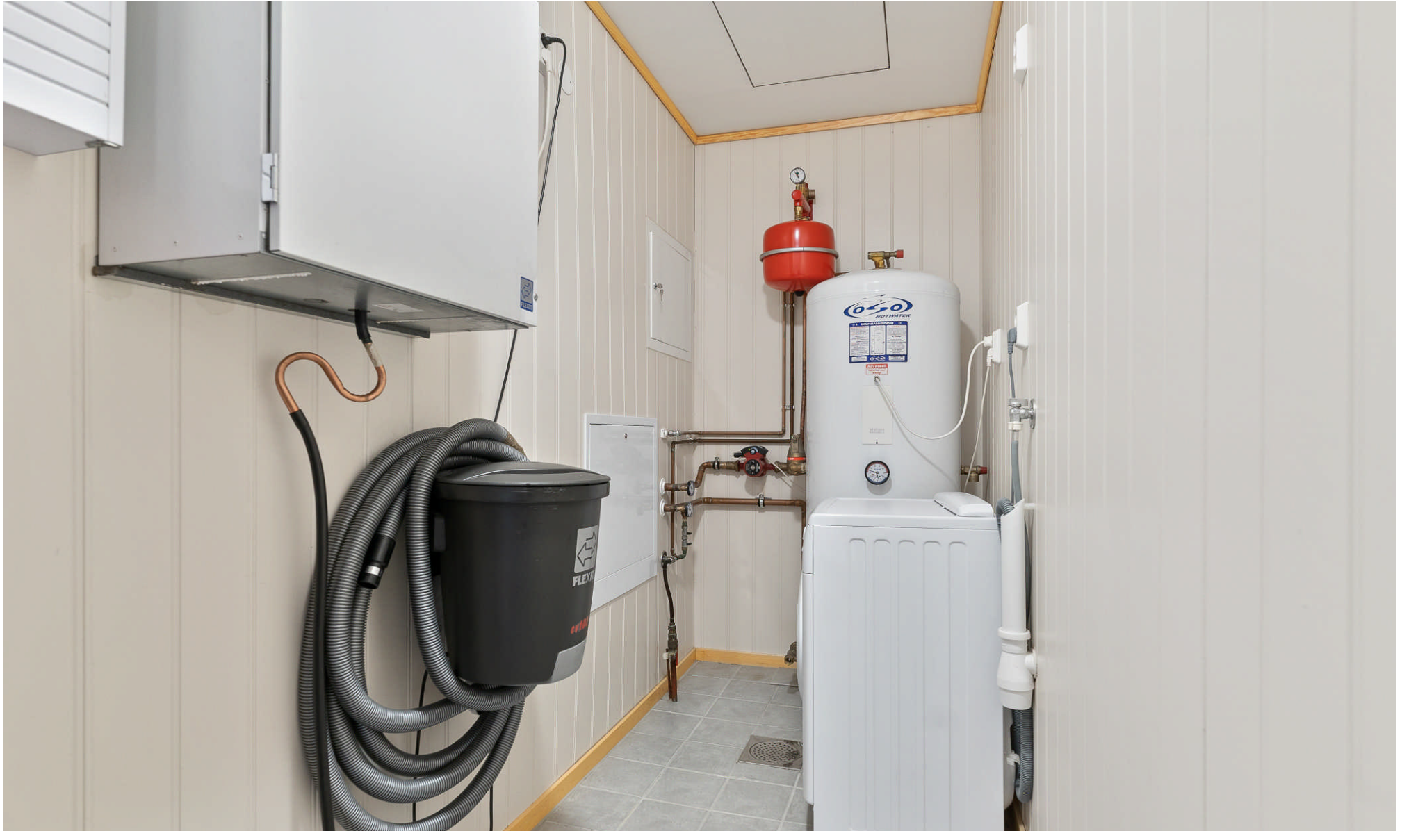
Vakserom og teknisk rom
