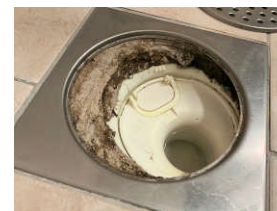
Bildet viser sluk i dusj.
