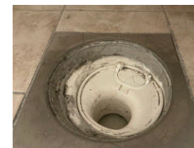
Bildet viser sluk under innredning.
