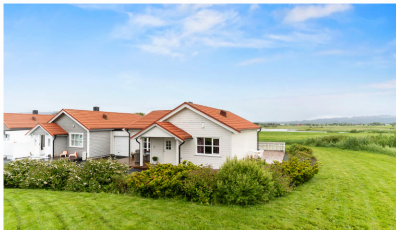
Fasade. Boligen ligger i enden på rekka
