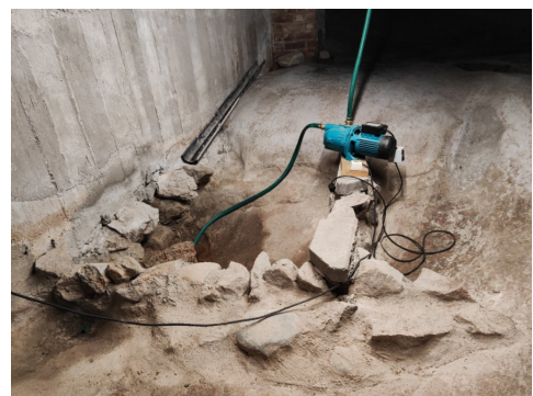
Fjellkulp med vannpumpe.
