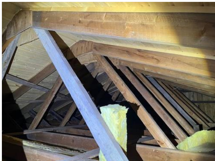
Loft - uinnredet / råloft - [Loft]
