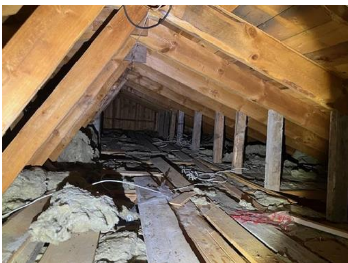
Loft - uinnredet / råloft - [Loft]
