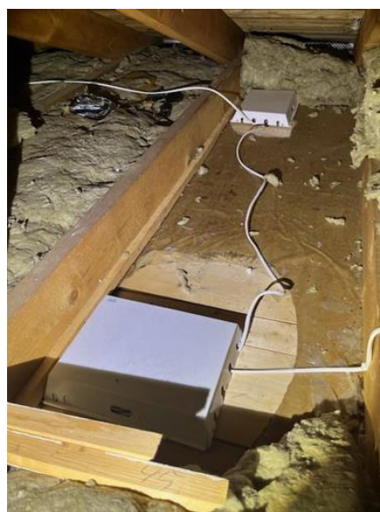
Loft - uinnredet / råloft - [Loft]
