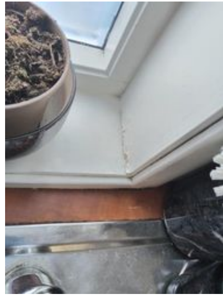
Vinduer - [Vindu på kjøkken ]
