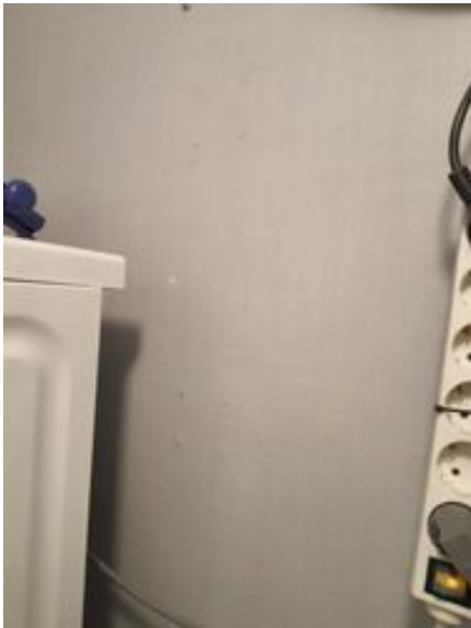
Overflater vegger - [Veggoverflater vaskerom ]
