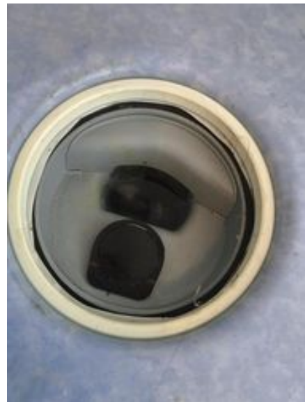
Slukets tilkomstmulighet for rengjøring - [Sluk i dusjsonen ]
