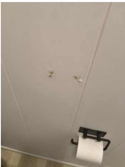
Overflater vegger - [Veggoverflater toalettrom ]
