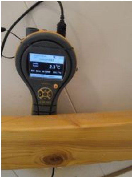
Fukt i tilliggende konstruksjoner - [Fuktmåling bad]
