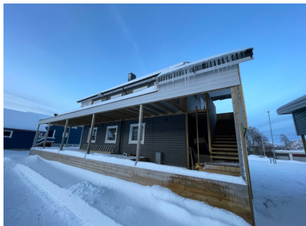
montert ventil der avtrekket kommer ut
