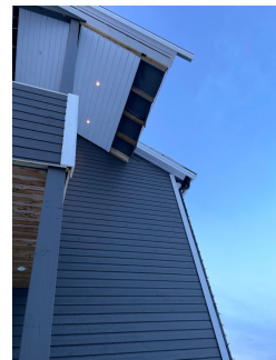
ferdigstilt med bord og takrenne og avløp
