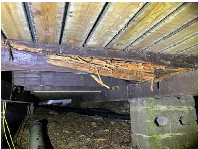
Terrasser på terreng (understøttet av bjelker / pilarer) - [Eksempel på råteskader terrasse]
