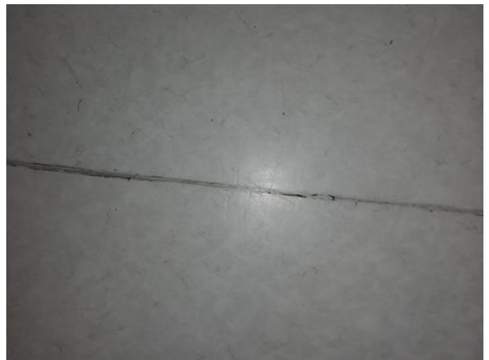
Beskrivelse - [Eksempel på utettheter i gulvbelegg på bad/vaskerom]
