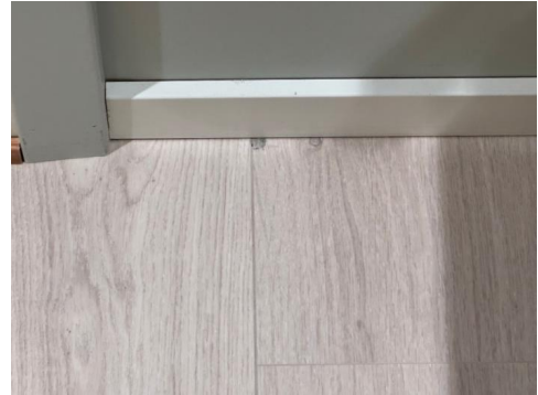
Sår i laminatgulv i stue. Må anses å være normal slitasje.
