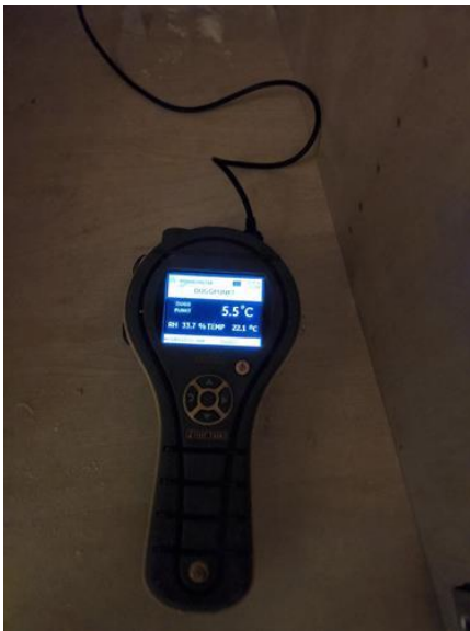
Fukt i tilliggende konstruksjoner - [Fuktmåling I dusjsonen ]
