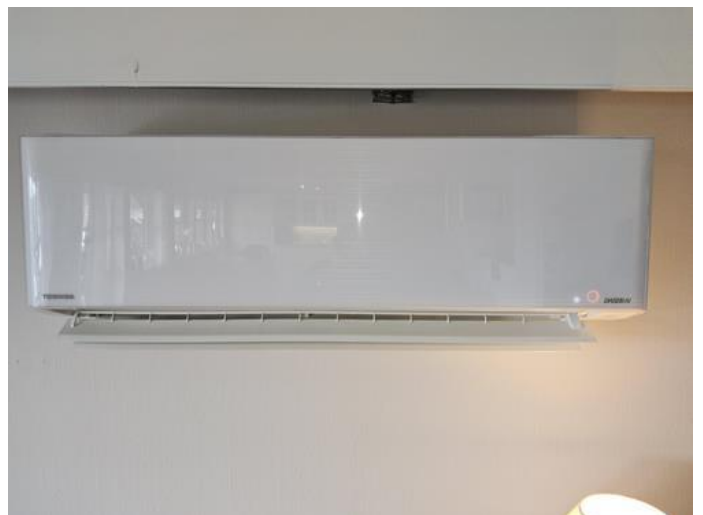
Tekniske anlegg, VVS anlegg (Sjekkpunkter utover det som er inkludert i andre rom)
