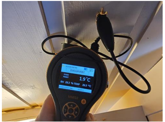
Våtrom - [Fuktmåling bad 1.etasje ]
