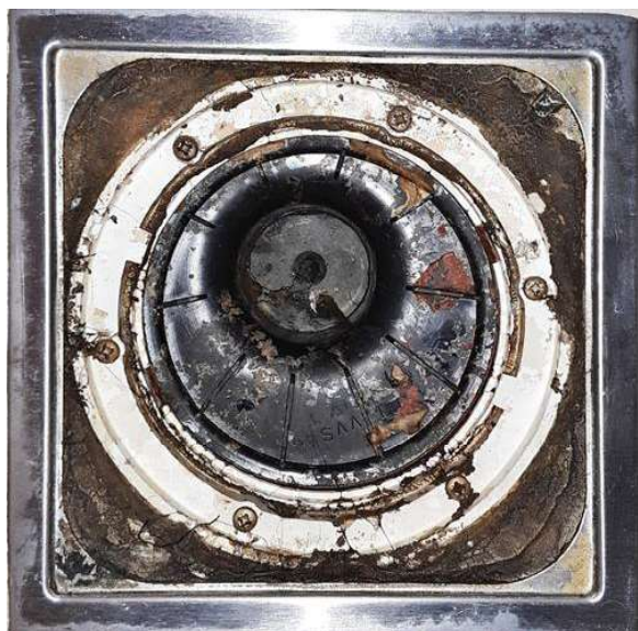
Våtrom - [Sluk bad]
