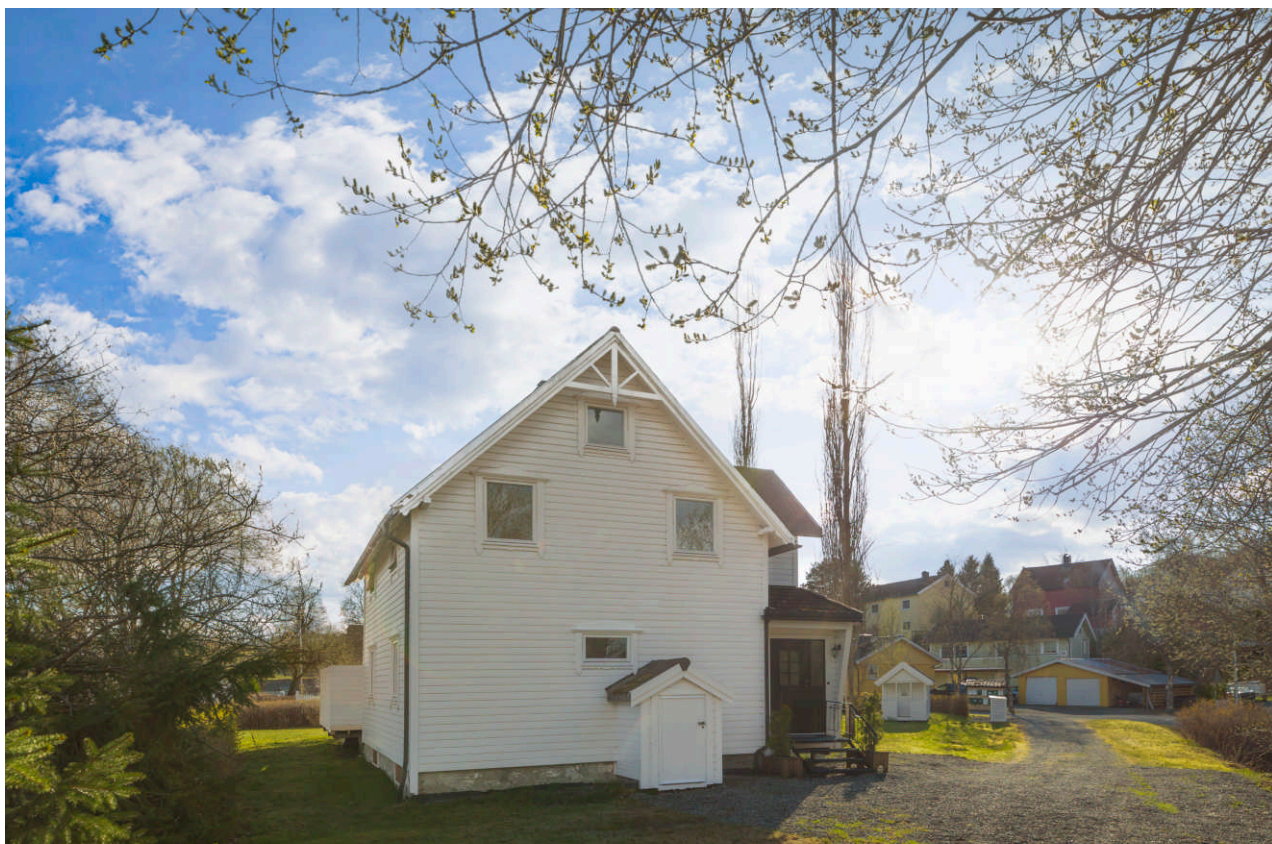
Ved inngangspartiet er det en egen nedgang direkte til kjeller.
