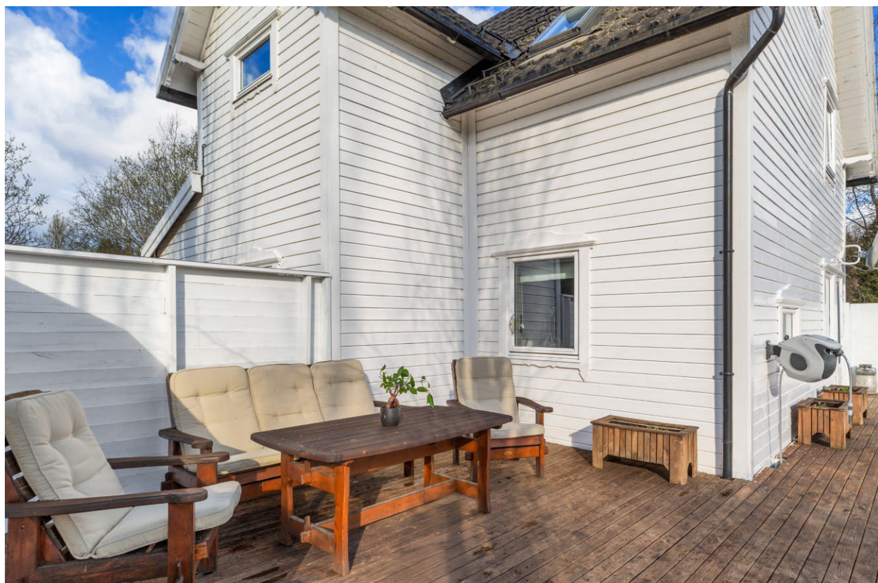
Det er vannuttak på veggen.
