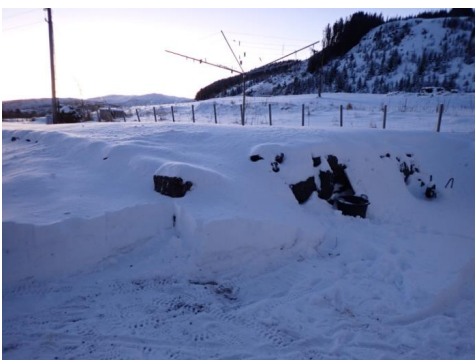
Mur i naturstein
