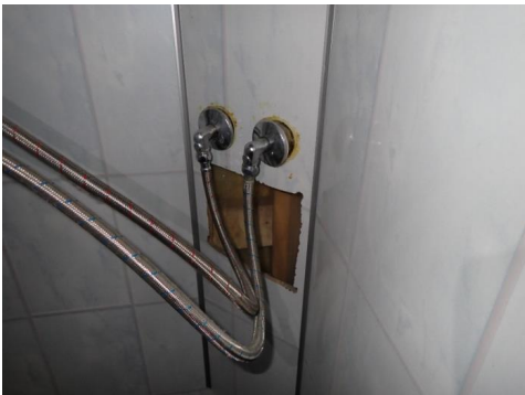
"Kasse" på vegg, skåret hull
