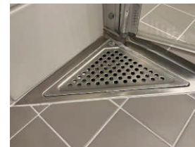
Det er Blücher slukrist. Sluk med gummipakning.
