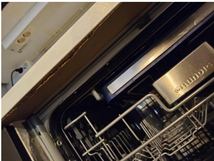
Kjøkken - [Skade på benkeplate (over oppvaskmaskin).]
