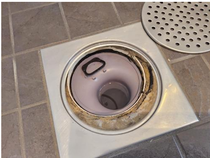
Våtrom - [Sluk på bad (dusjsonen)]
