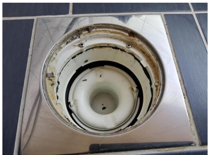
Slukets tilkomstmulighet for rengjøring - [Sluk i bad andre etasje.]
