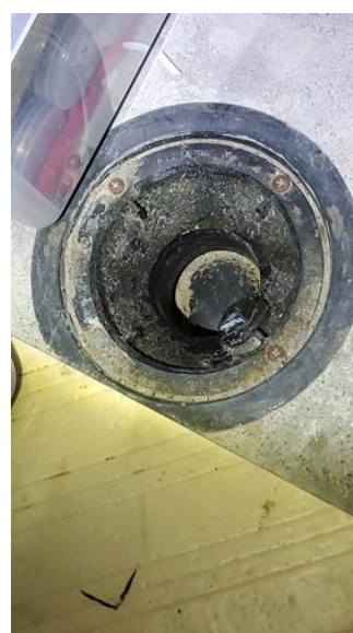
Avløpsrør. (Sjekkpunkter utover det som er inkludert i andre rom) - [Sluk i bod i underetasje]
