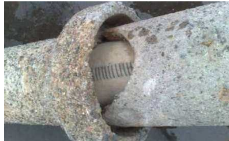
Illustrasjonsbilde rørfornyng med strømpe.
