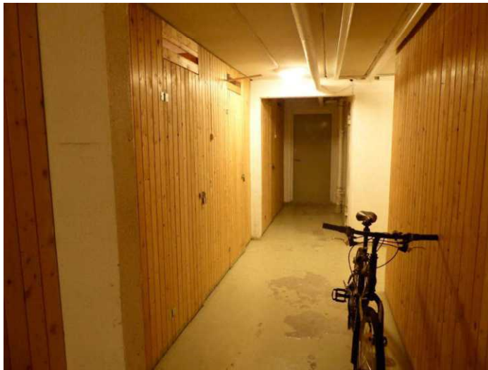
Tette boder med lufting over dør.
