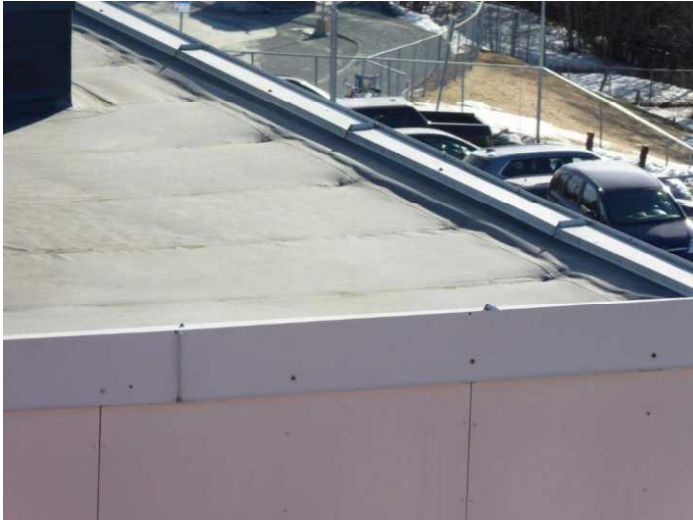
Taktekking i W.A. vei 12 blafret mye i vinden. Ser ut til tekking ikke lengre er tilstrekkelig festet.
