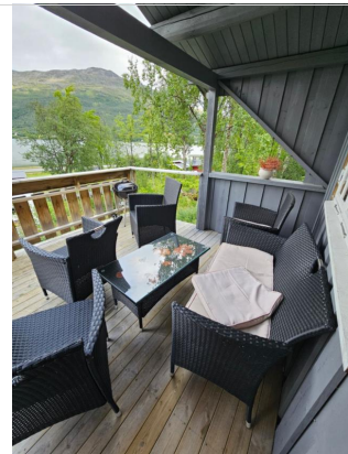
Mangler rekkverk på terrasse
