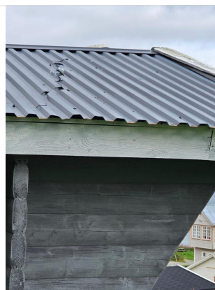
Papp flerret av på hyttetak begge sider, ikke funnet fukt inne.
