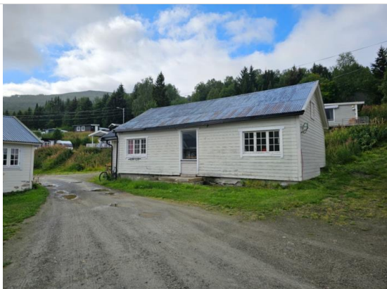
Synlige skader på grunnmur.
