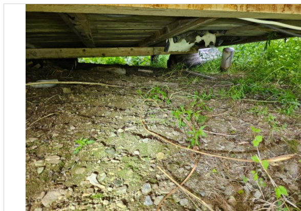
Utettheter i stubb under hytte nr. 19
