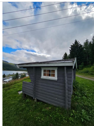
Papp flerret av på hyttetak begge sider, ikke funnet fukt inne.
