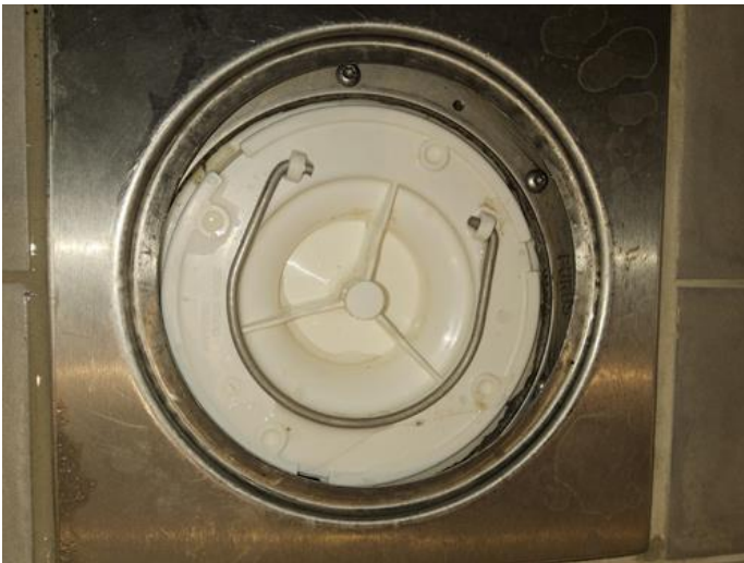
Membran, tettesjikt og overgang til sluk. - [Sluk]
