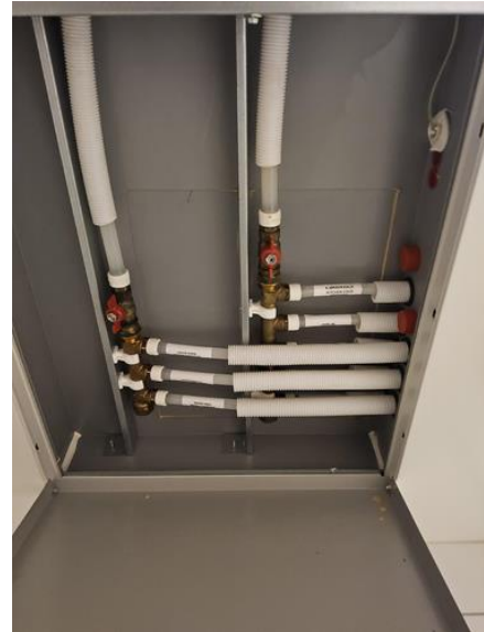
Vannrør - [Fordelerskap for rør-i-rør-systemet]
