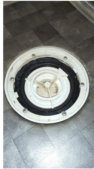
Avløpsrør (ink. sluk) - [Sluk bad]
