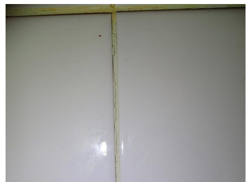
Eksempel på oppsprekking i fuger
