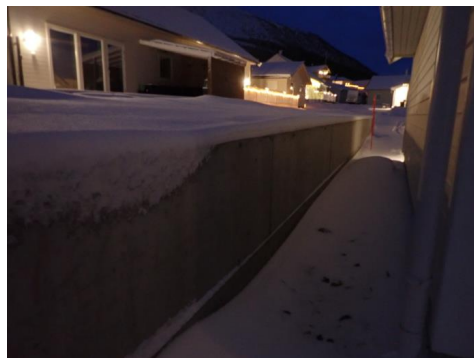
Forstøtningsmur i betong, her fra høyeste område
