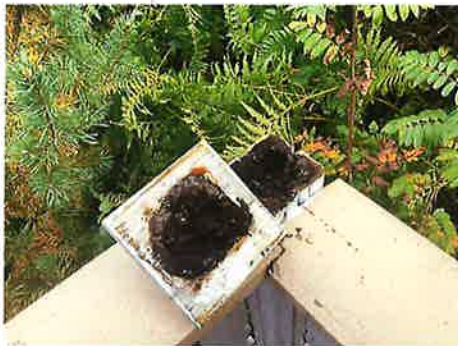
Råteskader på rekkverksstolpen
