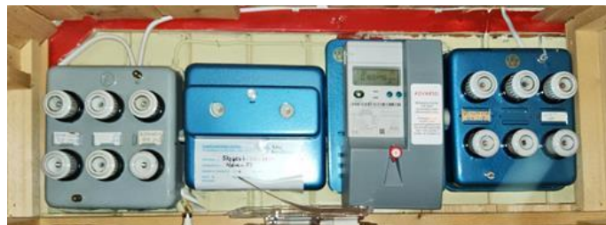
Forenklet vurdering av det elektriske anlegget - [Sikringsbokser Holme 25]
