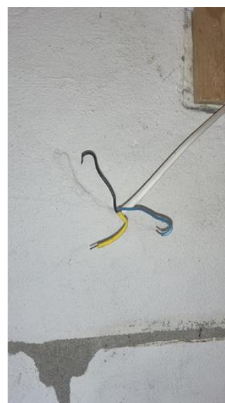
Forenklet vurdering av det elektriske anlegget - [Berøringsfare i kjeller bod]
