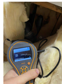
Fuktmåling viser ingen fukt i konstruksjonen.
