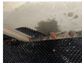
Synlig grunnmur under terrasse.
