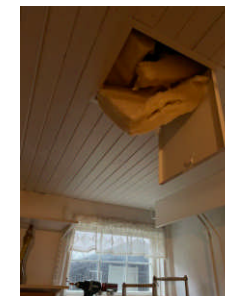
Inspeksjonsluke i himling, kjeller.
