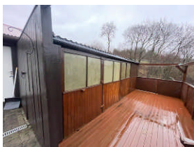
Balkong ved garasje.
