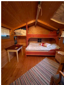
Innvendig er bygget bekledd med panel.
