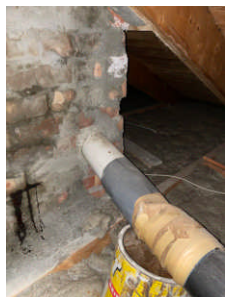
Pipe i tegl, med innvendig stålpipe.
