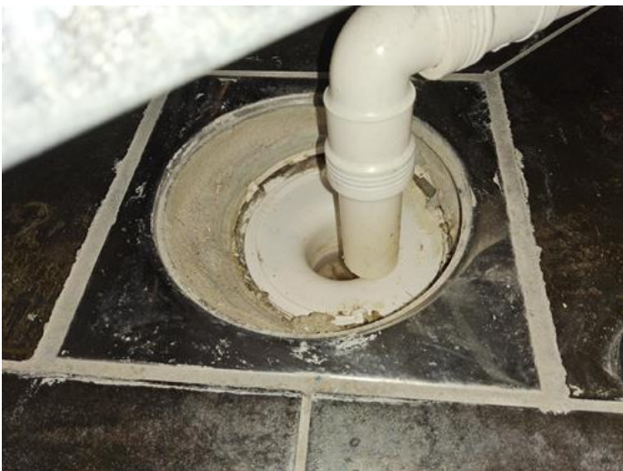
Våtrom - [Sluk bad 1.etg under badekar. ]
