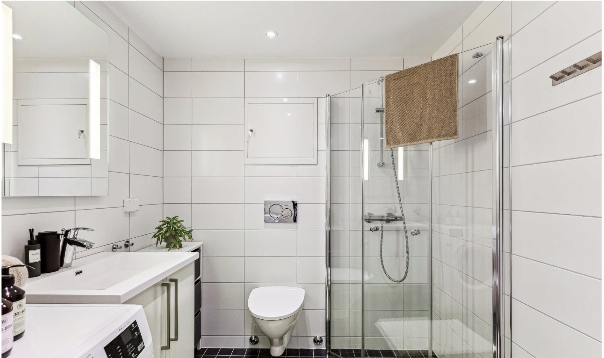
Badet er utstyrt med servantskap, mekanisk avtrekk, opplegg for vaskemaskin, veggmontert wc og innfellbare dusjdører.
