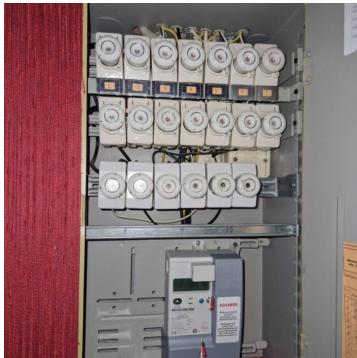
Sikringsskap med skrusikringer.
