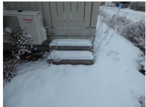
Trapp til veranda
