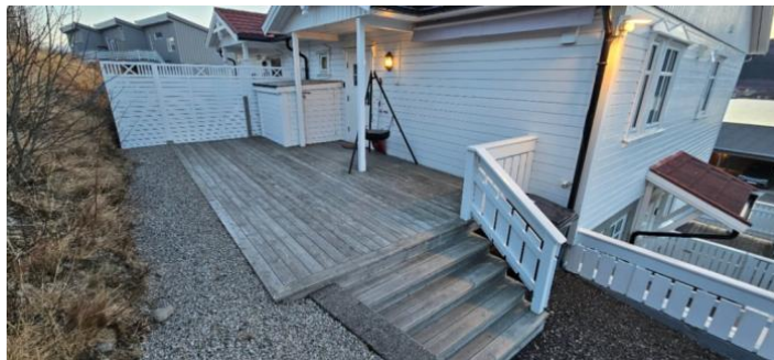
Balkong/repos mot nord.
