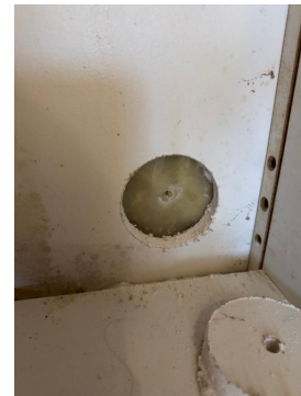
Plast på innside av påforet kjellervegg.
