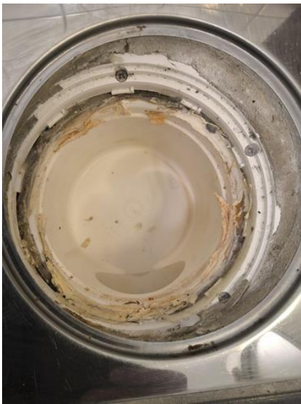
Slukets plassering i forhold til at vann utenfor dusjsonen kan nå det - [Sluk ved vaskemaskin]
