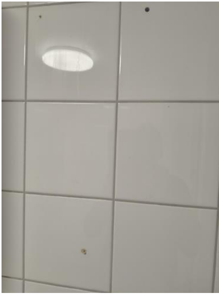
Overflater vegger - [Hull i veggfliser]
