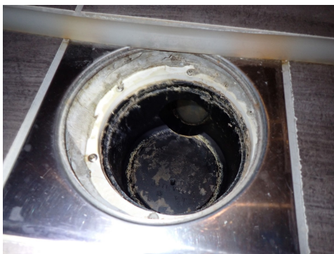
Sluk på bad/vaskerom
