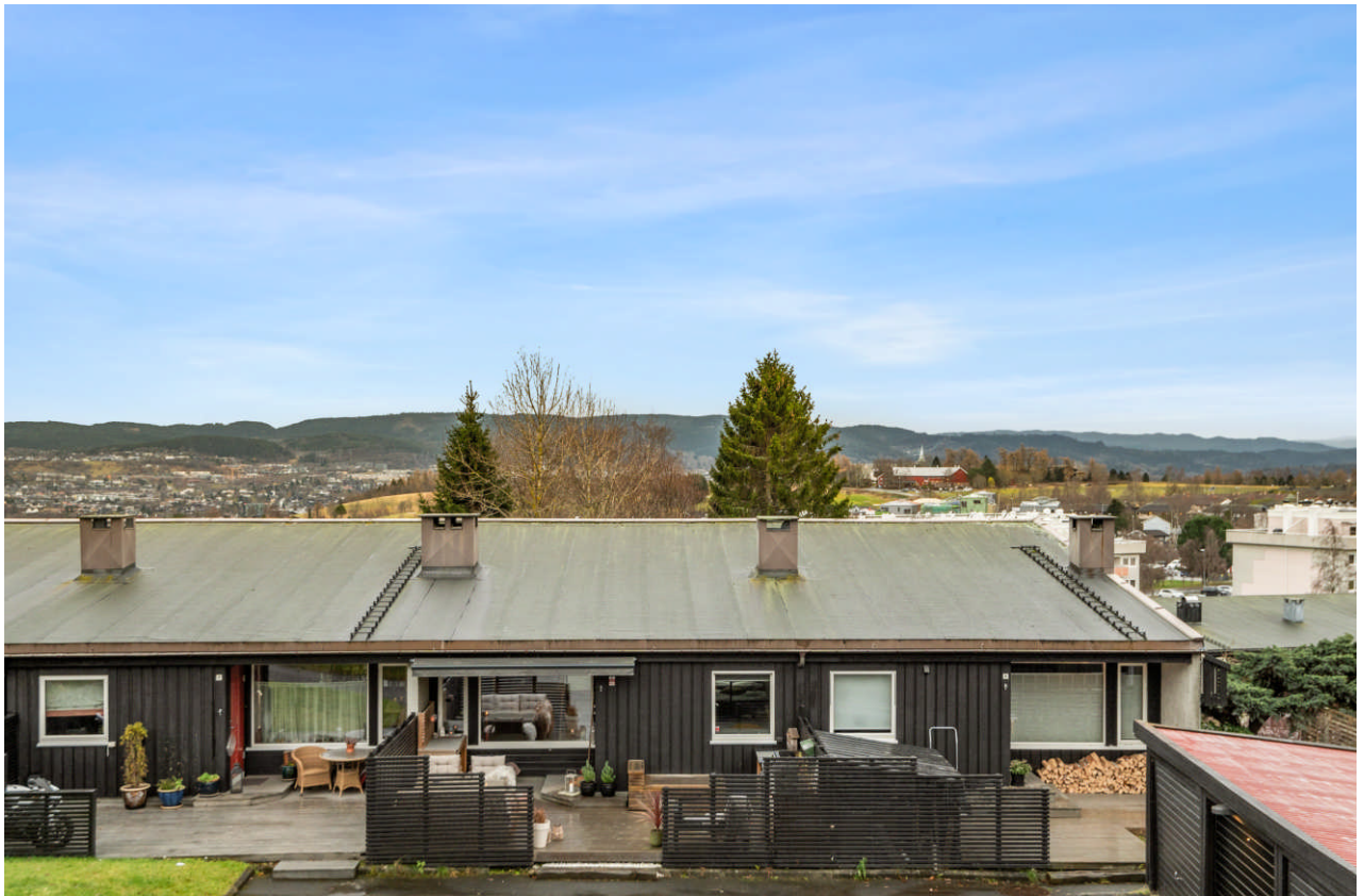
Bygget ligger fint til med kort, og trygg vei opp til Nyborg skole.
